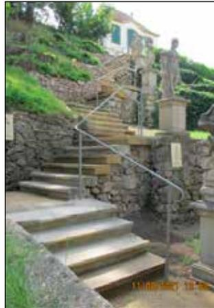
Aufgrabung zur Herstellung des Unterbaus für die Treppenstufen wurde festgestellt, dass hangseitig weder ein Stufenauflager noch Fels zur Gewährleistung der Standsi-
