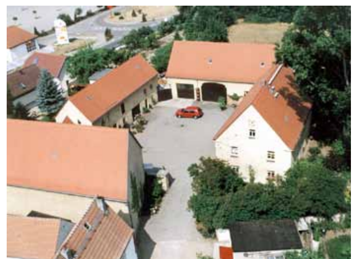
Abb. Vierseithof in Nünchritz
