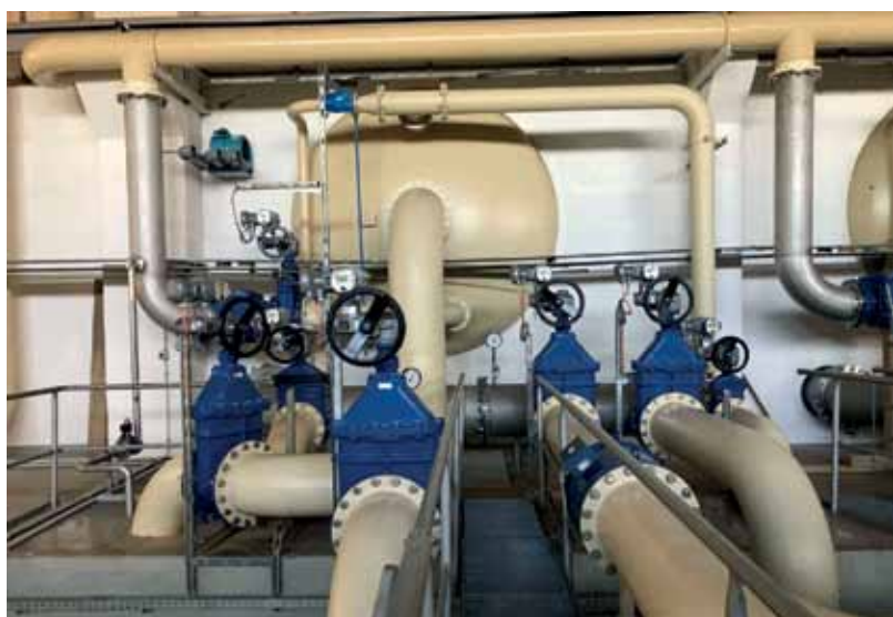
Die Filterarmaturen im Wasserwerk Fichtenberg werden erneuert.
