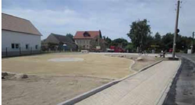
der Einbau von ca. 300 m<sup>2</sup> Betonökopflaster und 50m<sup>2</sup> Kleinpflaster, ca. 220 m<sup>2</sup> Dynamische Schicht und Deckschicht einer wasser- gebundenen Wegedecke, ca. 170m Betonhoch-, rund- und tiefbord, ca. 150 m<sup>2</sup> Betonrechteckpflaster für die Gehwegneuanlage und den Längsparkstreifen, ca. 75m<sup>2</sup> Asphalttrag- und deckschicht für die Anpas-
