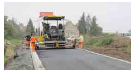
Einbau der Asphaltdecke auf der Erschließungsstraße „Neue Straße“ in Merschwitz
