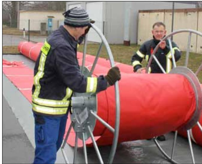
zunächst mit Luft gefüllt, damit es mit wenigen Helfern optimal ausgerichtet und gesichert werden kann. Mit dem anschließenden Austausch der Luft durch Wasser erreicht ein Schlauchelement von 15m Länge ein Gesamtgewicht von ca. 6 Tonnen, welches einen wirksamen Schutz vor Überflutung bietet. Die Aufbauzeit für einen zu schützenden Abschnitt mit Sandsäcken würde sich zirka auf das 12-fache erhöhen. Dabei ist noch nicht berück-
